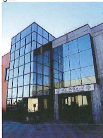
La sede della Fin-Beton
