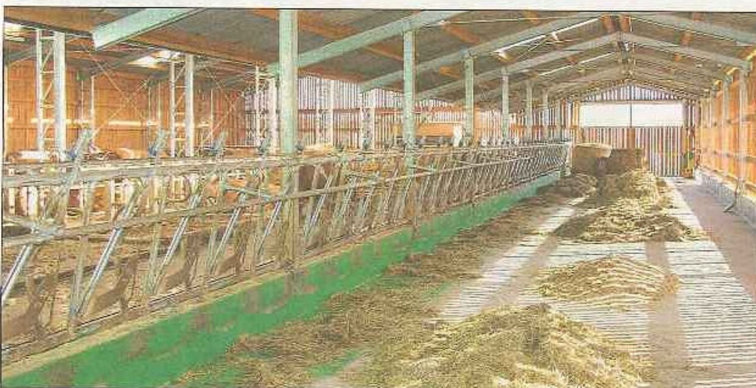
Der Futtertisch des Stalls auf dem Betrieb Priewasser besteht ebenfalls aus Betonfertigteilen. Die Stahlkonstruktion dieses Gebäudetrakts hat 4,50 Meter Firsthöhe.
