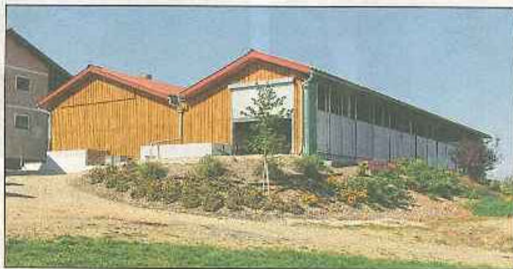
Vor dem zweihäusigen Stall der Familie Lechner fällt das Gelände stark ab; deshalb waren aufwendige Unterbauarbeiten notwendig.
