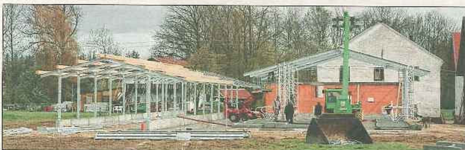
Aufstellung und Stahlkonstruktion waren innerhalb von vier Tagen montiert.
